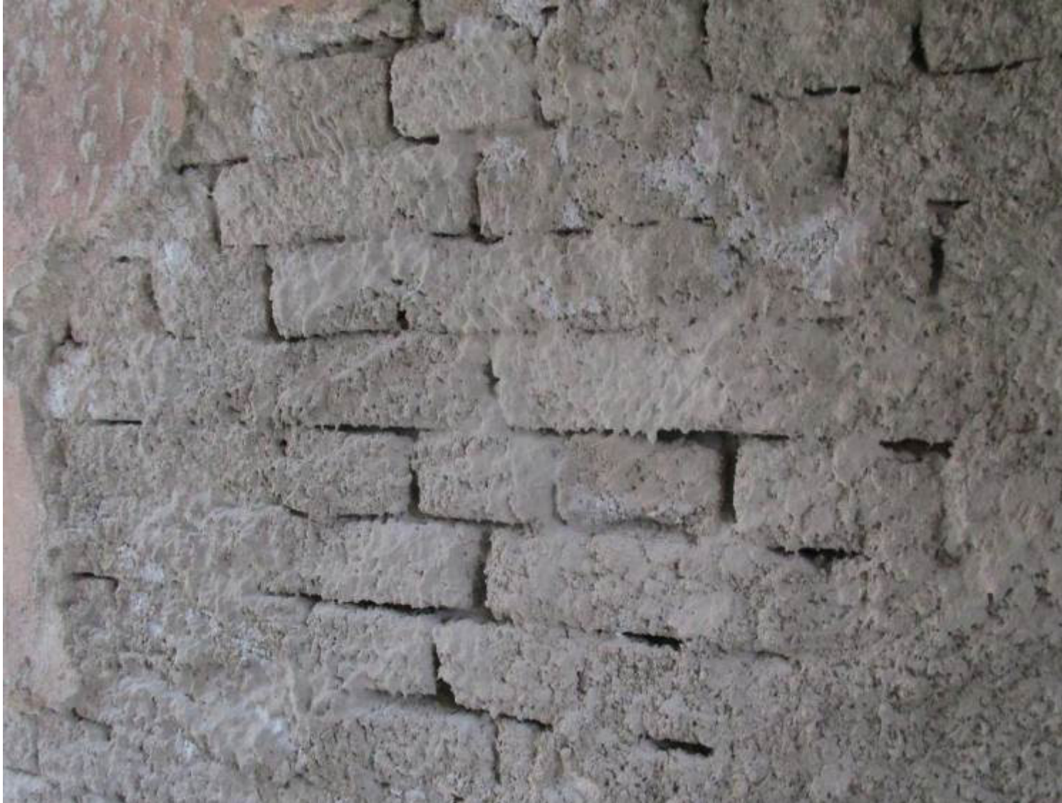
Илл. №2 Необходимость производства работ по заделке кладочных швов до нанесения обрызга обусловлена недопустимостью формирования воздушных полостей между кладкой и штукатуркой
