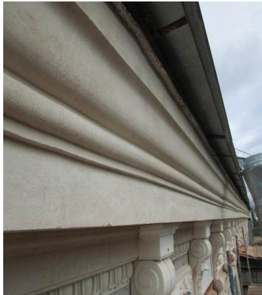
Илл. 8 Протягивание профилированных тяг по шаблонам: слева - в грубозернистой штукатурке; справа - в финишной (накрывочной) штукатурке
