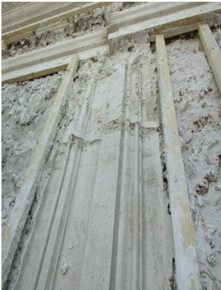
Илл. 8 Протягивание профилированных тяг по шаблонам: слева - в грубозернистой штукатурке; справа - в финишной (накрывочной) штукатурке
