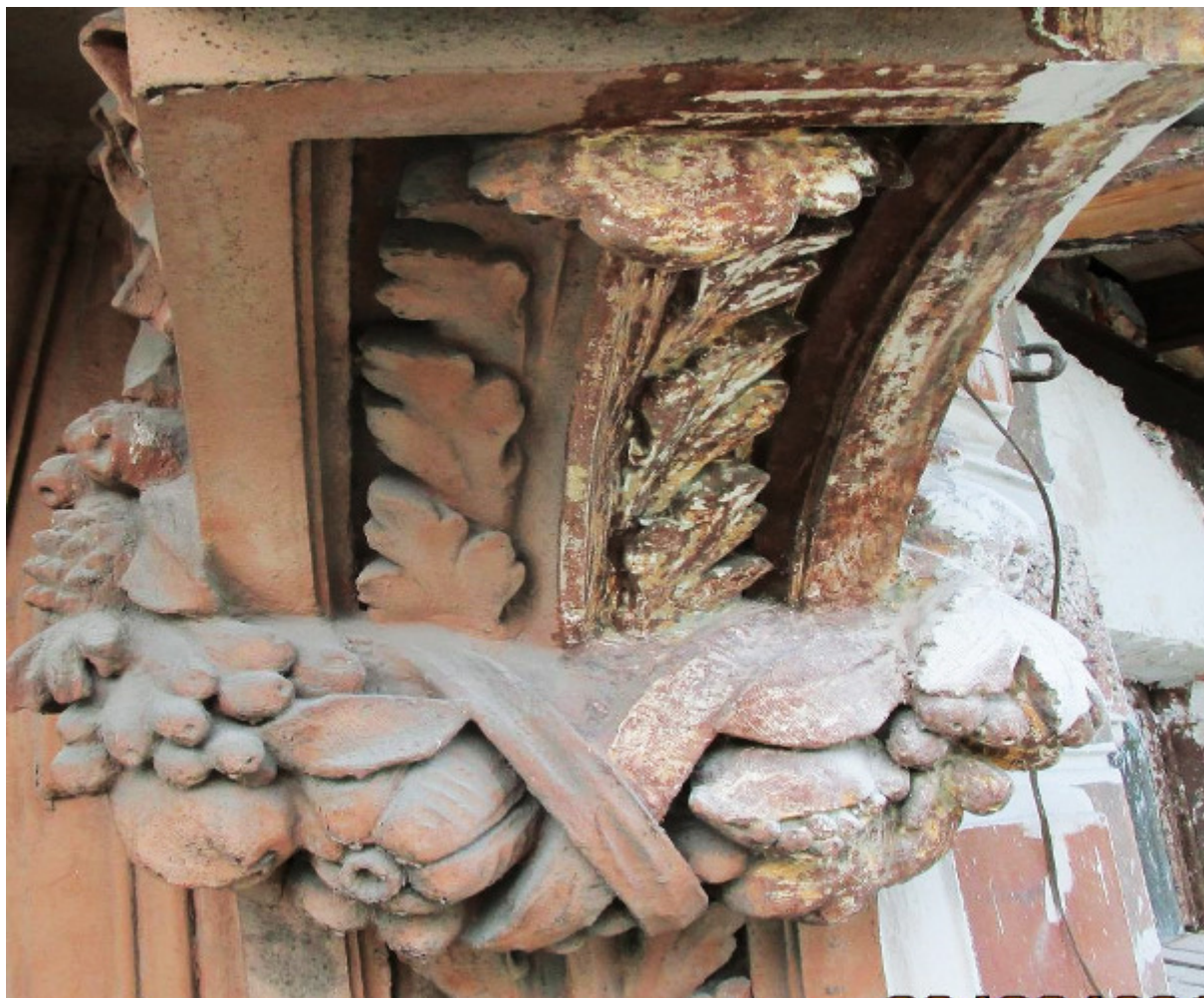
Илл. 9 Расчистка лепнины смывками для удаления старой краски
