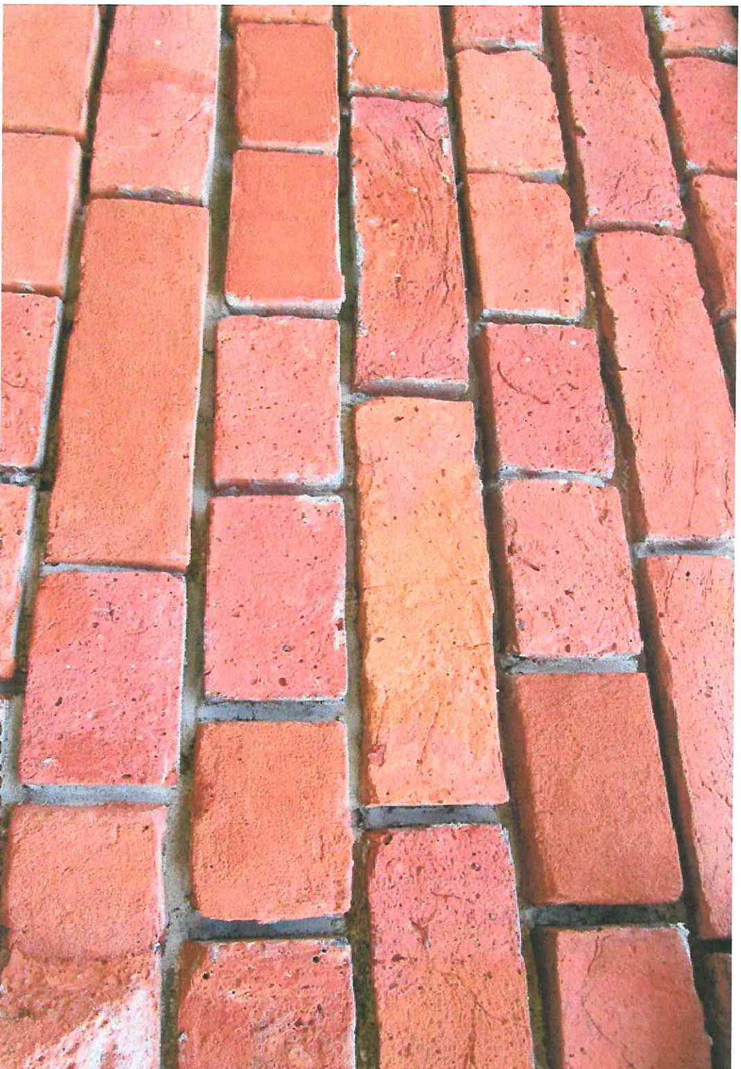
Докомпоновка камнезаменителем
