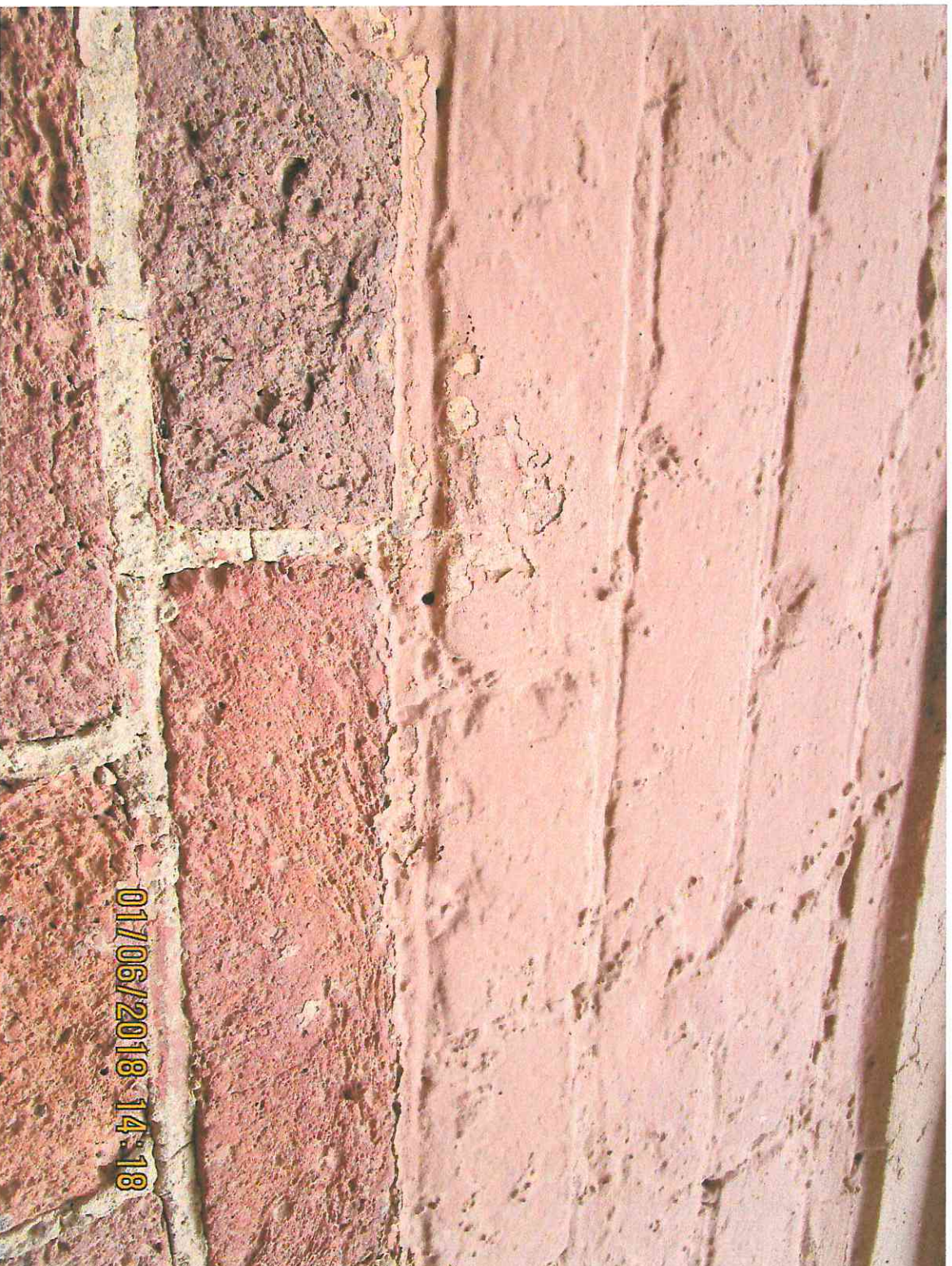
Вне зависимости от финишной отделки кирпичной кладки воздушно-абразивная обработка целесообразна для восстановления паропроницаемых характеристик фасада
