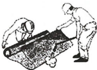
Наклейка расплавленного конца рулона
