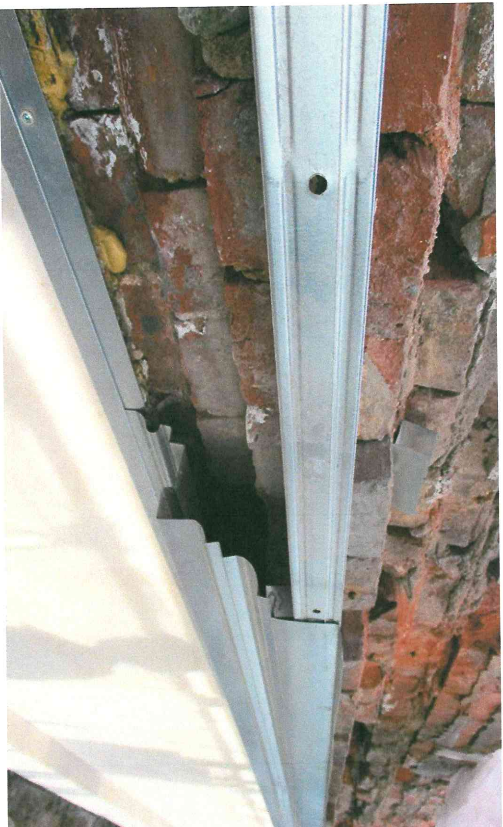
Илл. 16 Металлический венчающий карниз, закрепленный к кирпичной кладке с помощью металлического профиля
