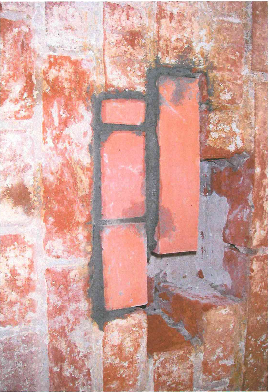
Илл. 3 Выщипка кирпичной кладки с установкой на сложный раствор
