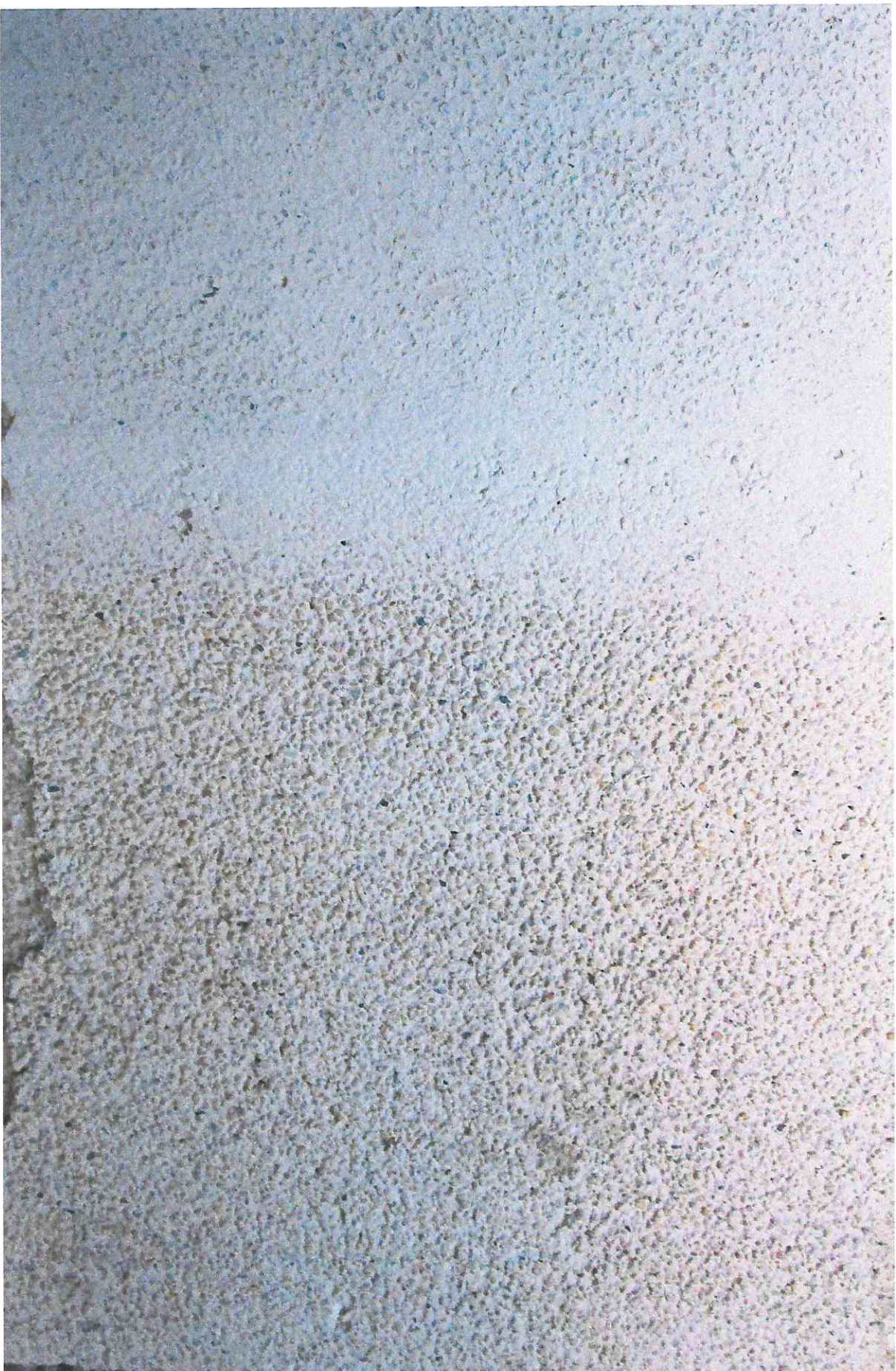
Илл. 6 Удаление цементно-известкового молока воздушно-абразивной обработкой
