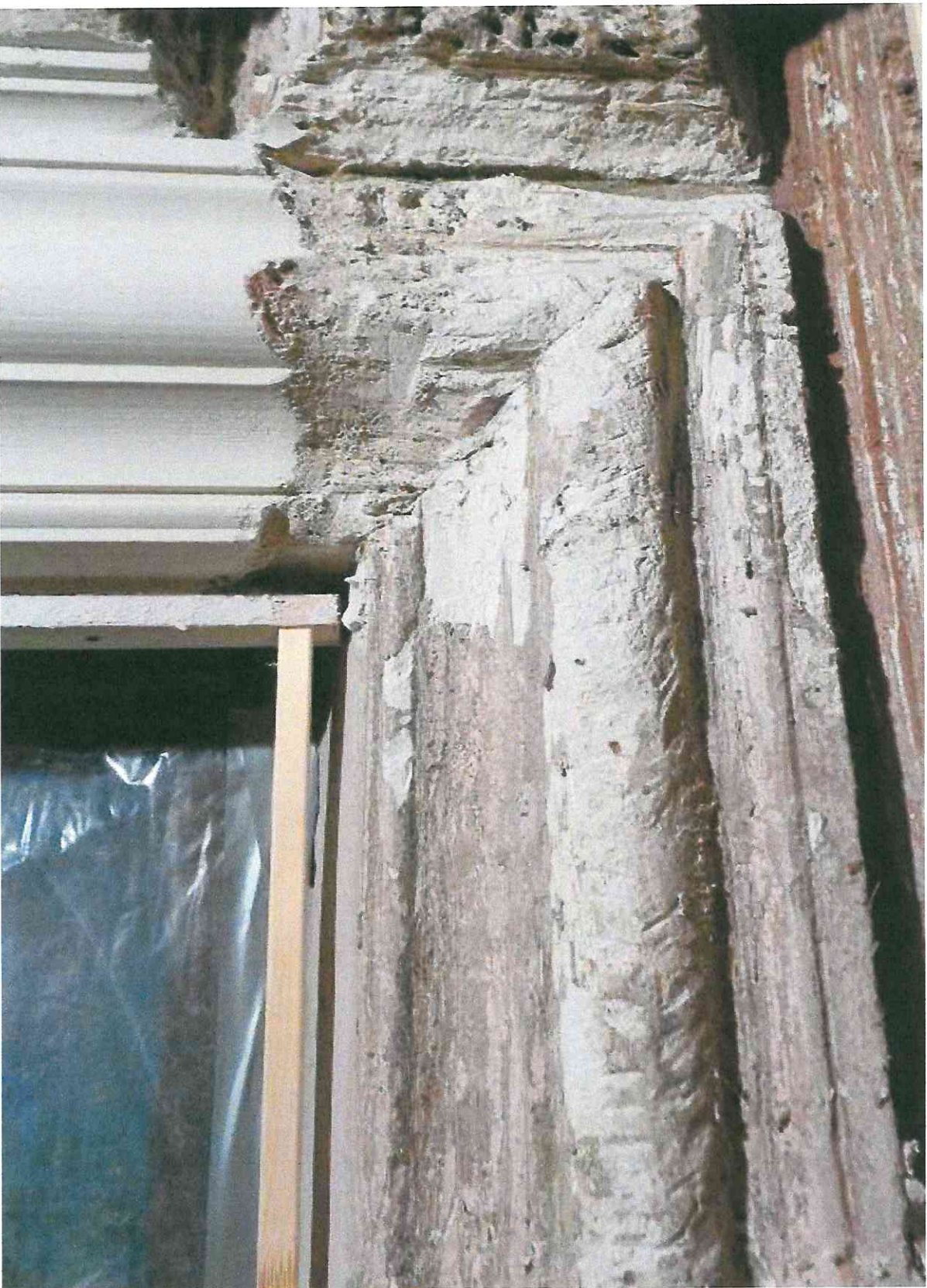
Илл. 8 Скалывание поверхности с утраченным профилем, укрепление остова и пролягивание накрывочной штукатуркой.
