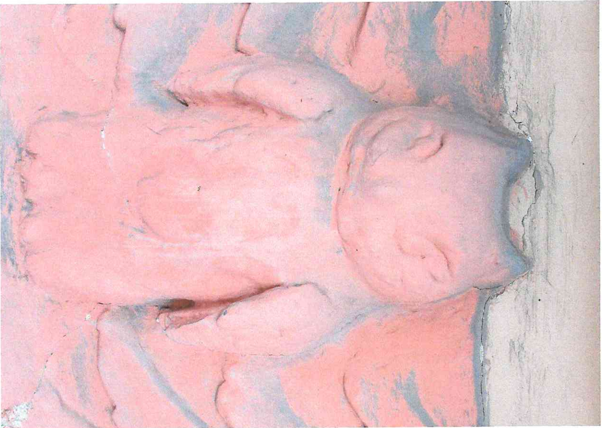
Илл. 9 Замыленный элемент, не подлежащий восстановлению, и новая отливка в фибробетоне
