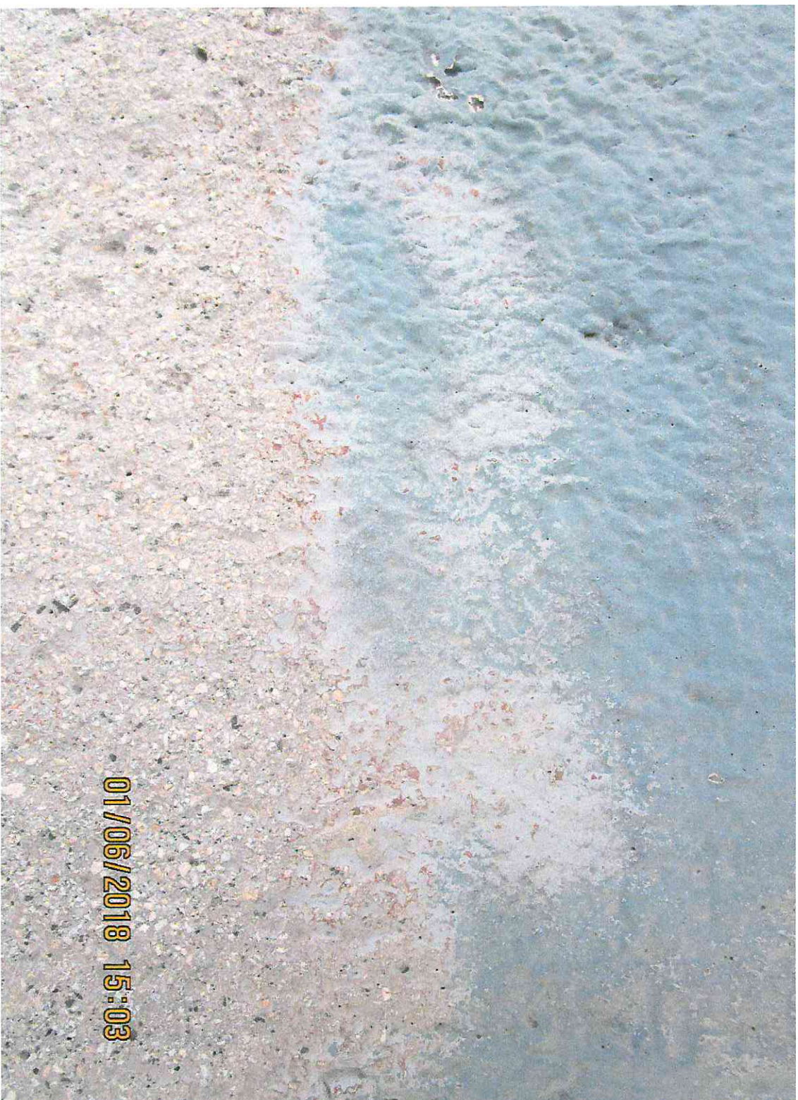
Илл. 2 Расчистка декоративной (каменвидной) штукатурки воздушно-абразивной обработкой от краски и железнящих составов
