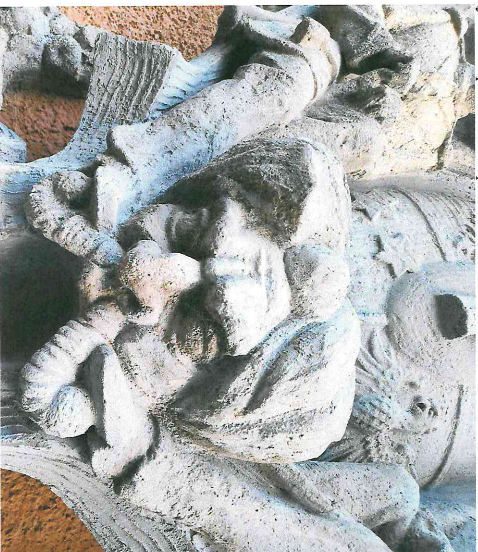
Илл. 11 Восстановление утрат и офактуривание лепного декора, выполненного в камневидном составе
