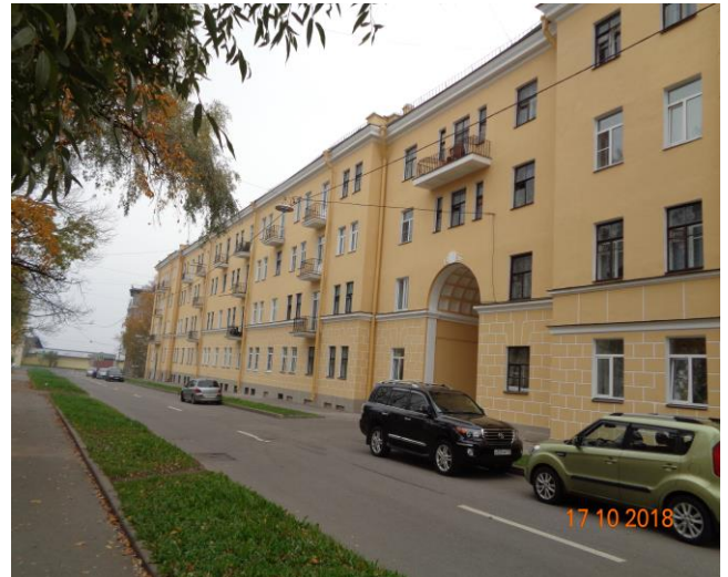
ПОСЛЕ КАПРЕМОНТА Пролетарская ул., д.18
