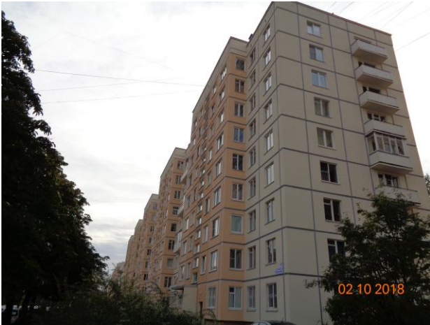
ПОСЛЕ КАПРЕМОНТА Большая Пороховская ул., д.41
