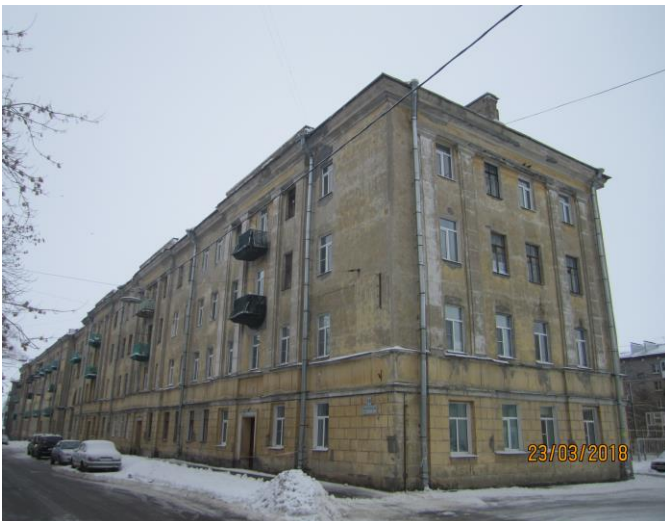
ДО КАПРЕМОНТА Пролетарская ул., д.18
