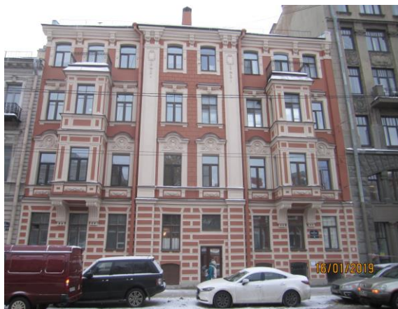
ПОСЛЕ КАПРЕМОНТА 1 линия В.О. д.24
