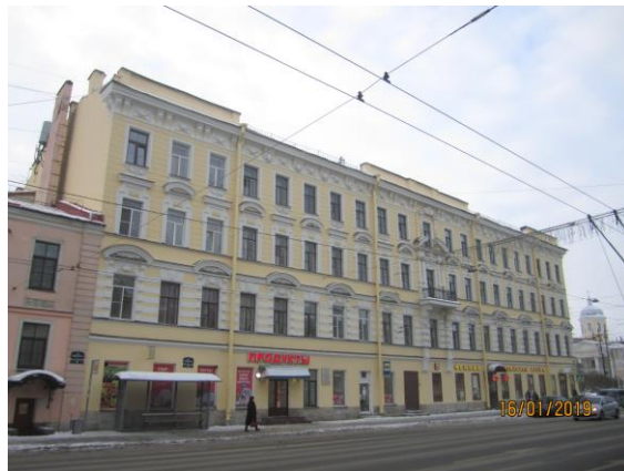
ПОСЛЕ КАПРЕМОНТА 1 линия В.О. д.18
