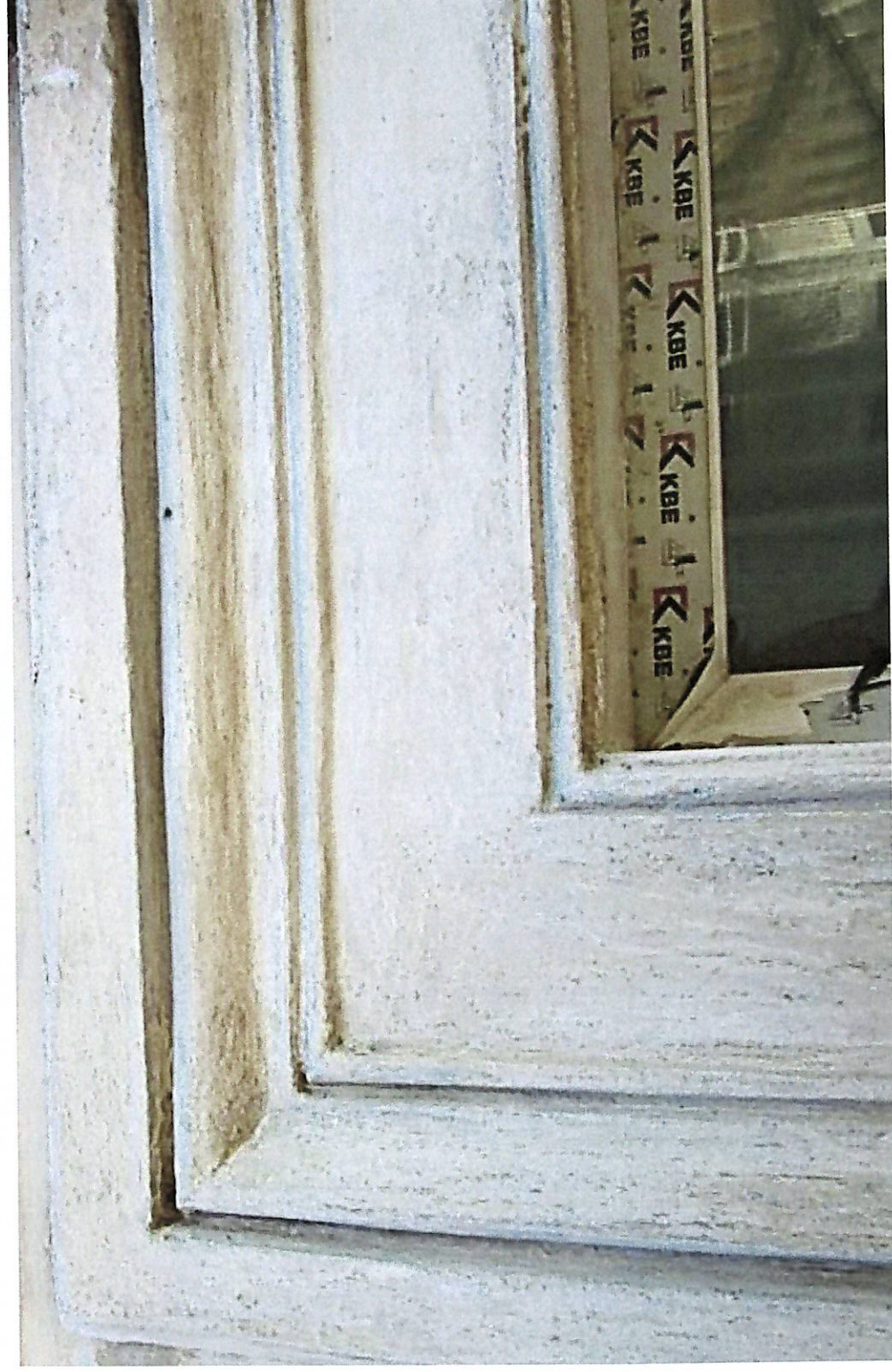
«Сухая» расчистка профилированного элемента шлифовальным полотном, стамеской и надфилем (в углублениях)
