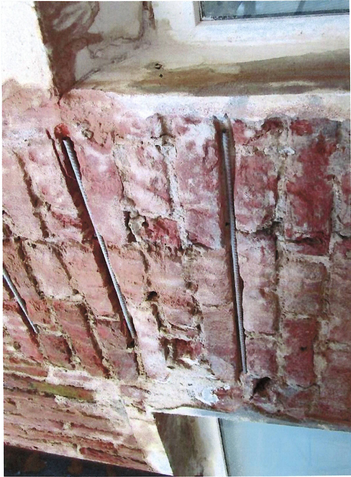
Установка арматуры в кладочный шов. Предварительное заполнение штробы сложным раствором обязательно!
