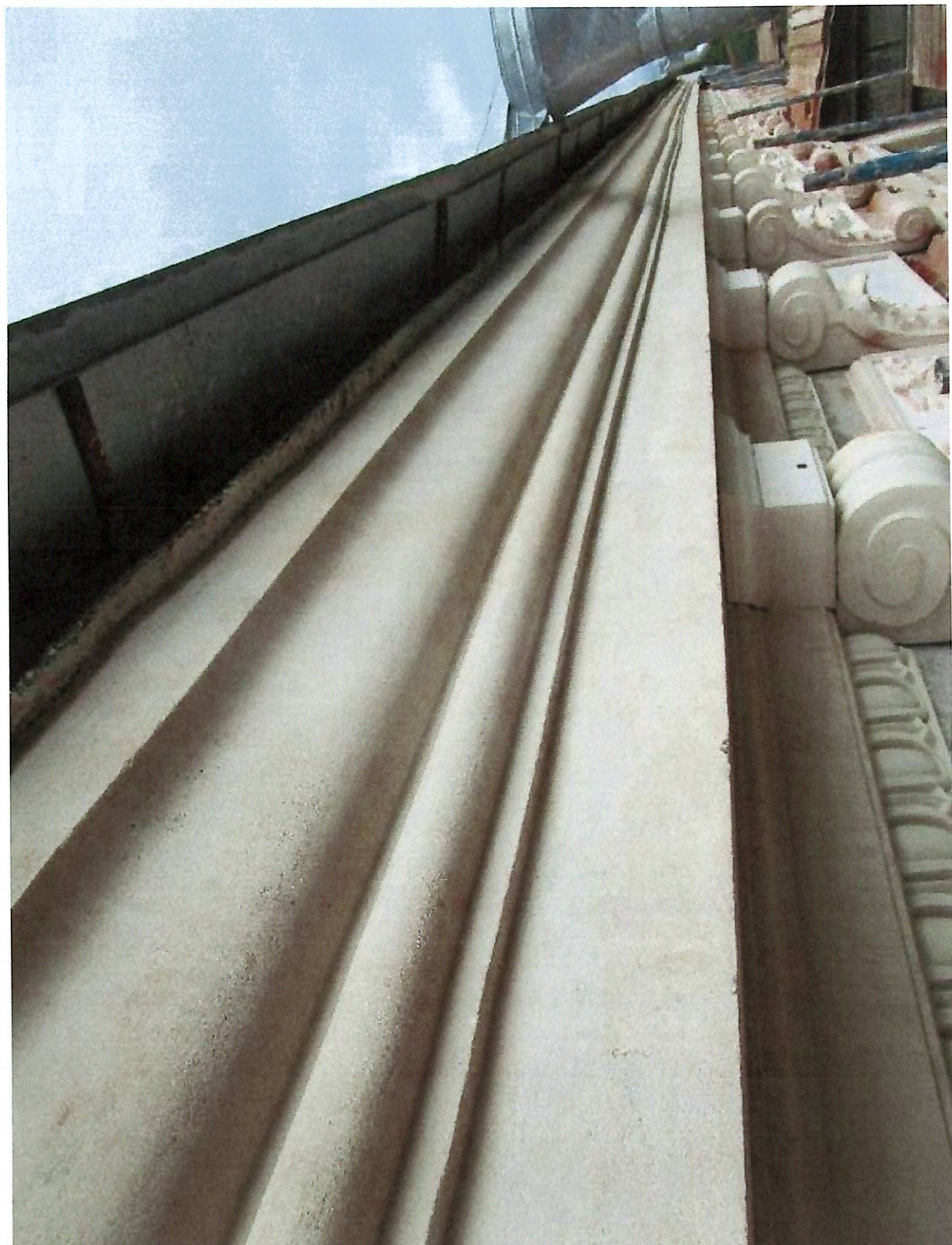
Протягивание профилированных тяг по шаблону в финишной (накрывочной) штукатурке
