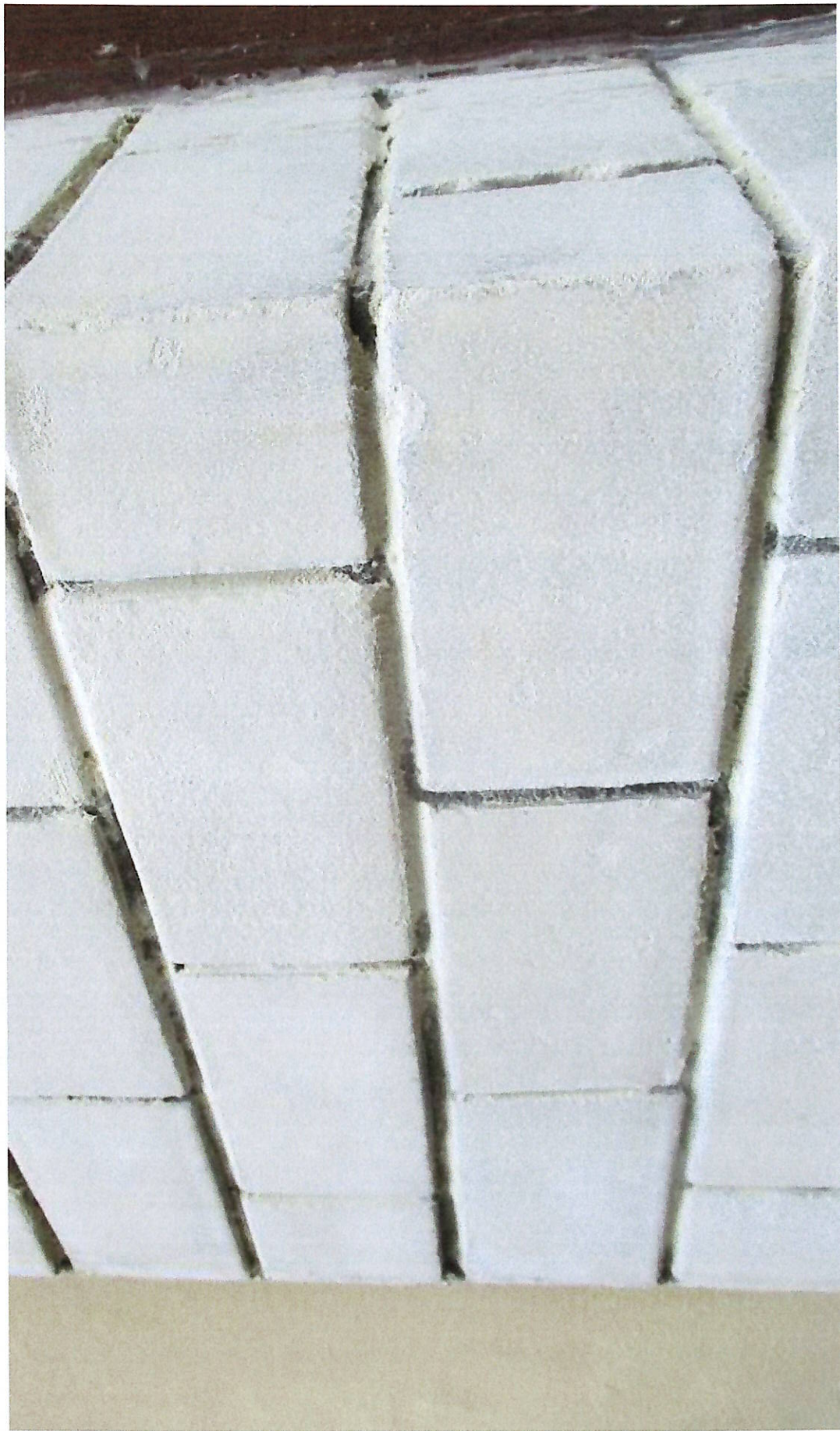
Докомпоновка каверн и сколов «кабанчика» камнезаменителем
