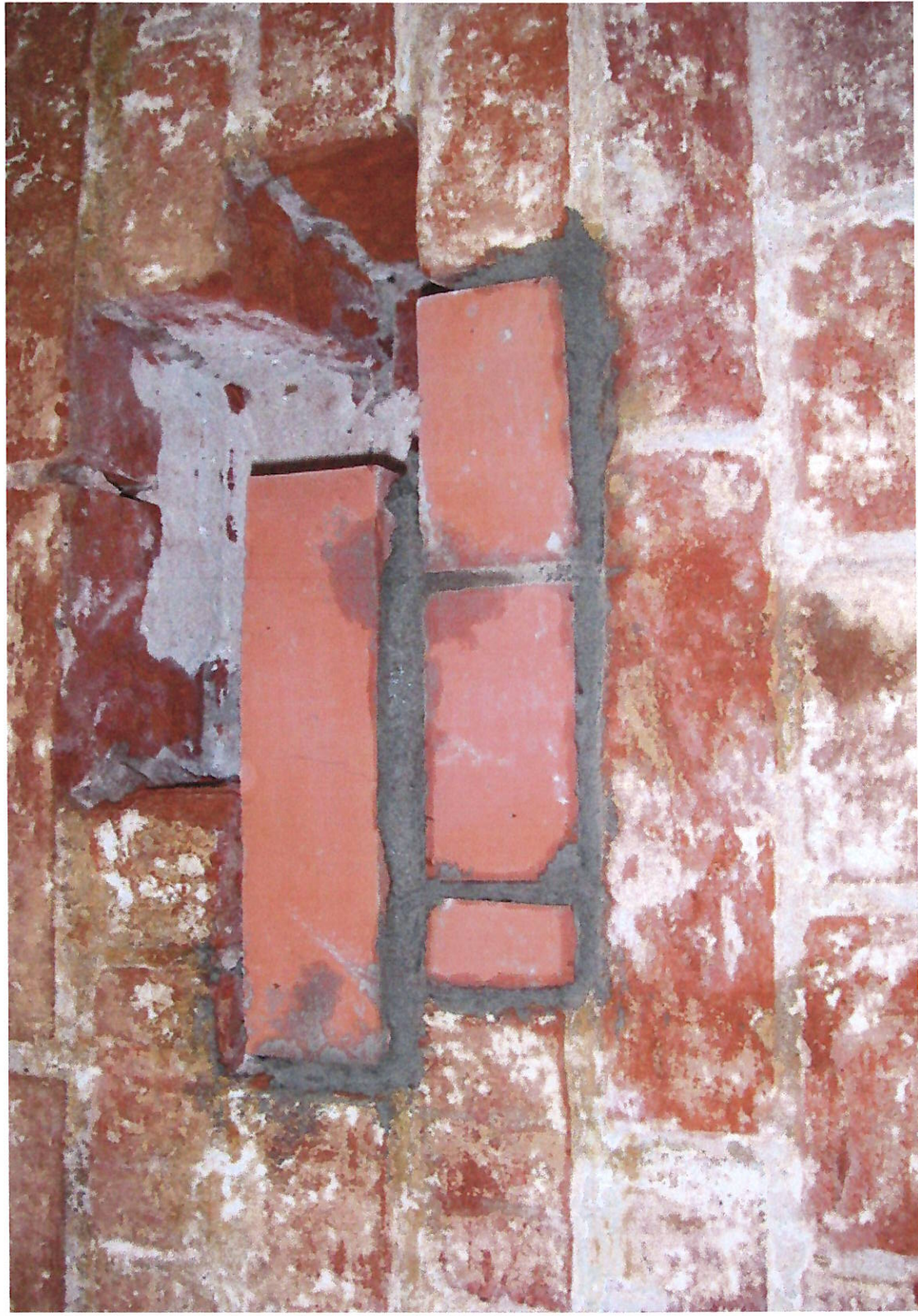
Выщипка кирпичной кладки с установкой нового кирпича на сложный кладочный раствор
