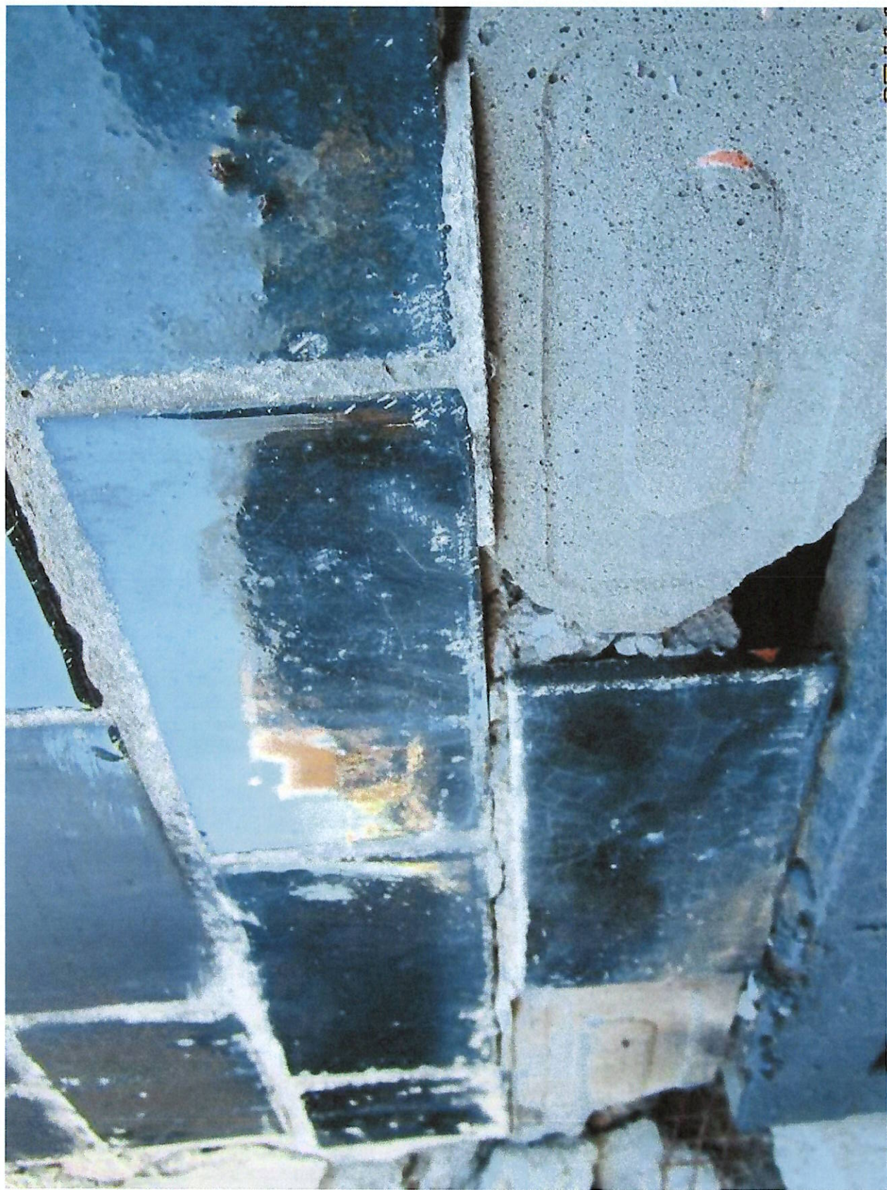
Ковровая облицовка глазурованной фасадной плиткой в зоне застройки второй половины XX века
